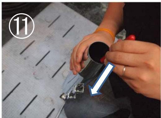
11 ボルトに特殊ワッシャーを取り付ける
